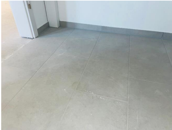
Neubau – Fußboden alle Räume
