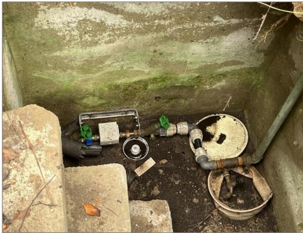
Abbildung 21: Grundstückswasseranschluss
