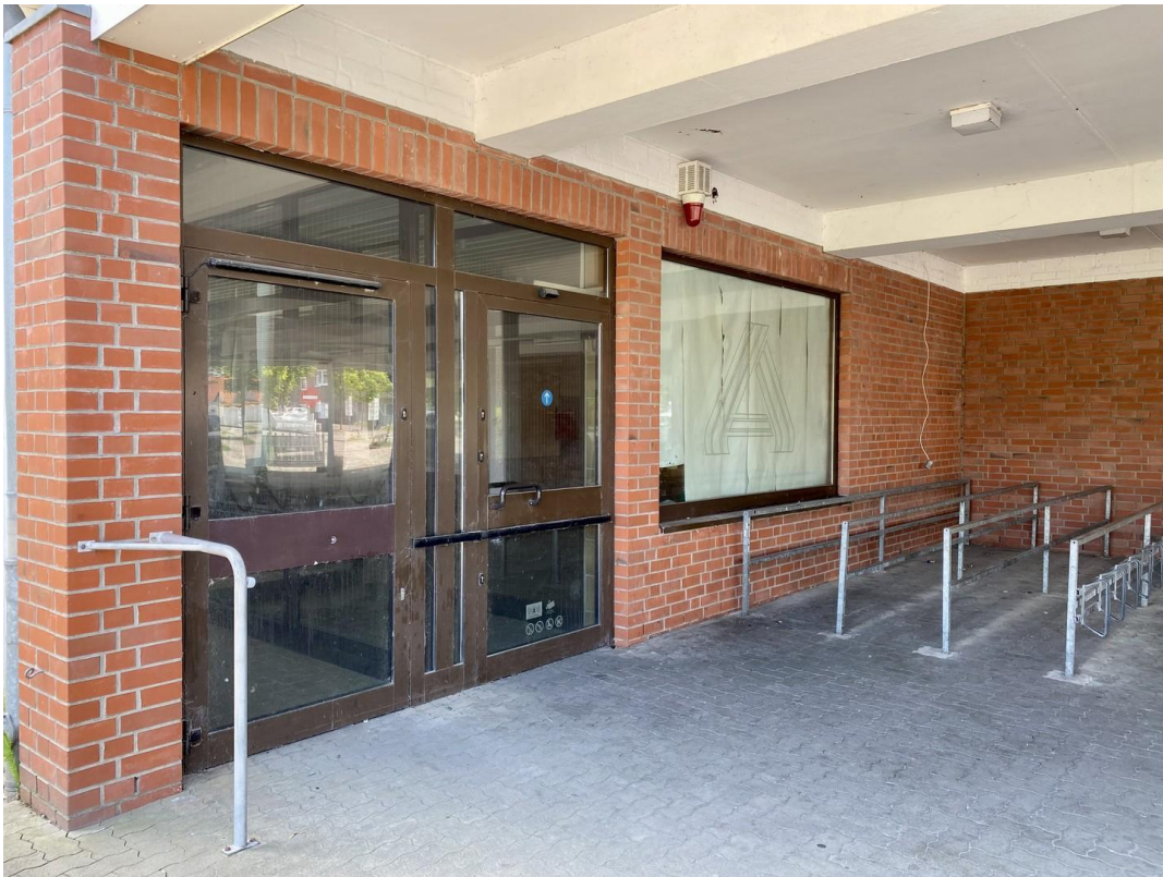
Zugang ehem. ALDI
