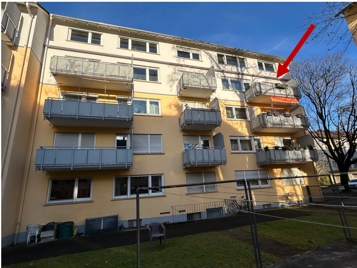
Hausansicht von Süden
