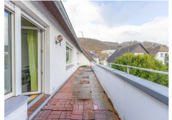
Balkon (wird noch saniert)
