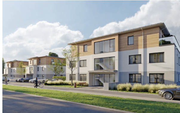
3 Mehrfamilienhäuser + 8 Doppelhaushälften | Ruderatshofen
