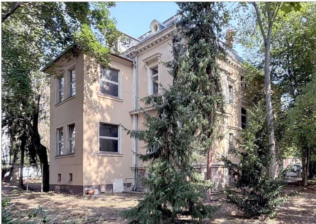
Hausrückseite mit Anbau
