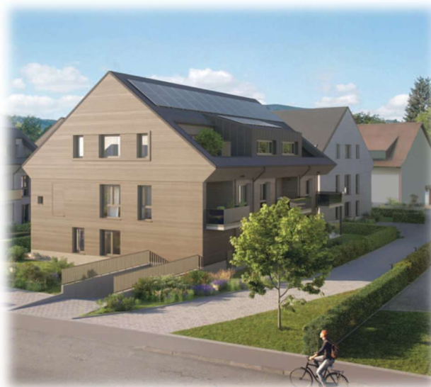
Haus A (Straßenansicht )
