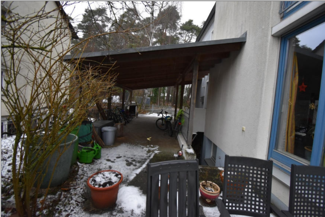
Blick entlang der Westgrenze nach Norden auf den Carport
