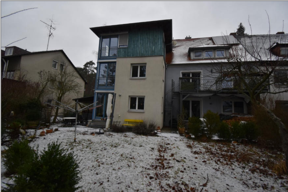
Blick von der südlichen Grundstücksgrenze aus nach Norden auf das Wohnhaus
