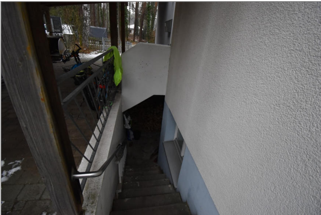
Kelleraußentreppe an der Westseite des Anbaus
