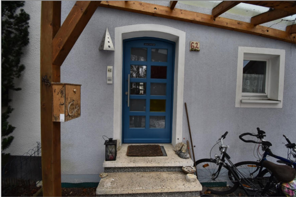
Altbau, Hausnr. 62, überdachter Hauseingang und Fahrrad-abstellbereich an der nördlichen Traufseite des Wohnhauses
