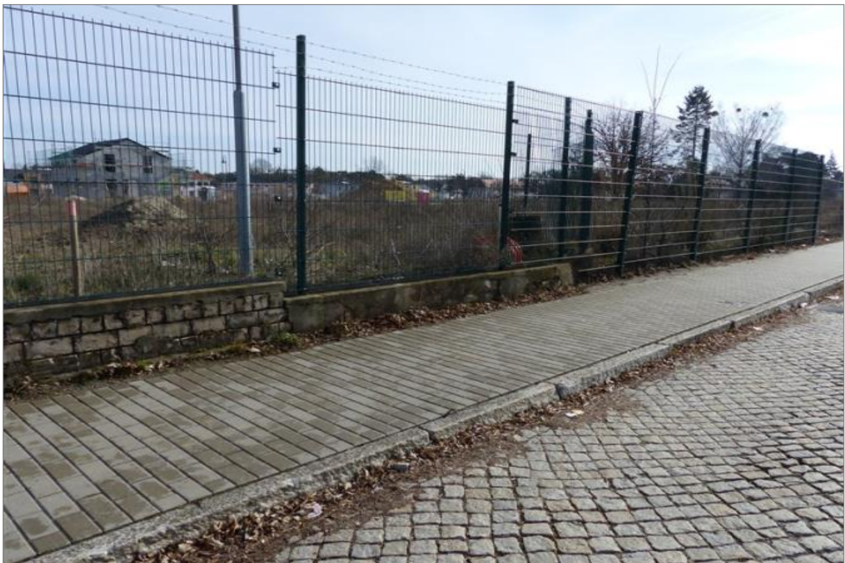
Abbildung 4: Blick Richtung „Heinrich-Zille-Straße“
