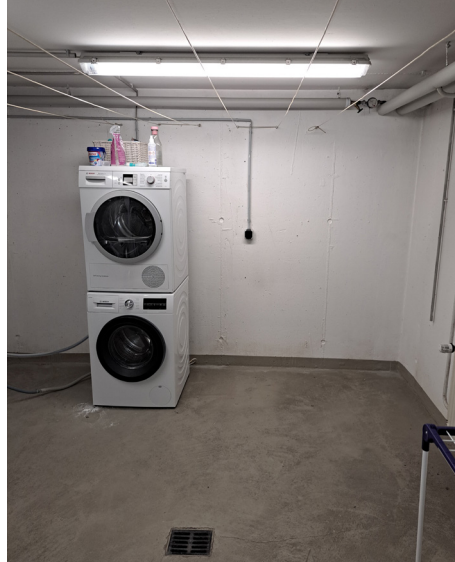
Waschmaschinenraum im UG
