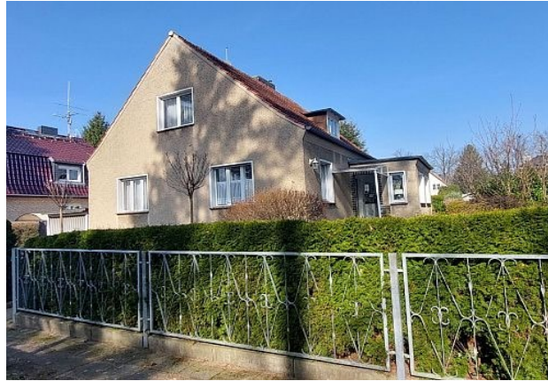
Haus mit 4 bis 5 Zimmern und Keller
