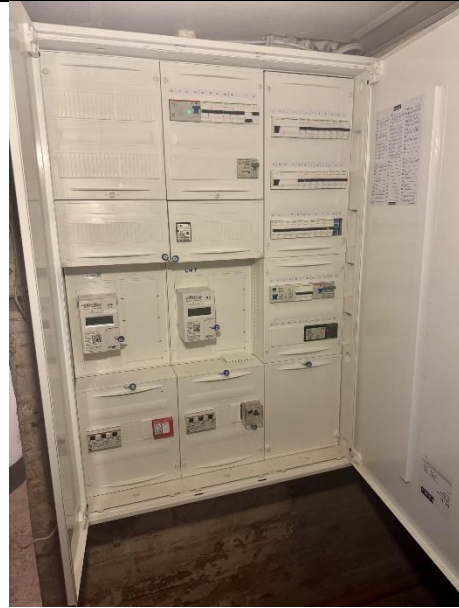
neuer Stromverteilerkasten
