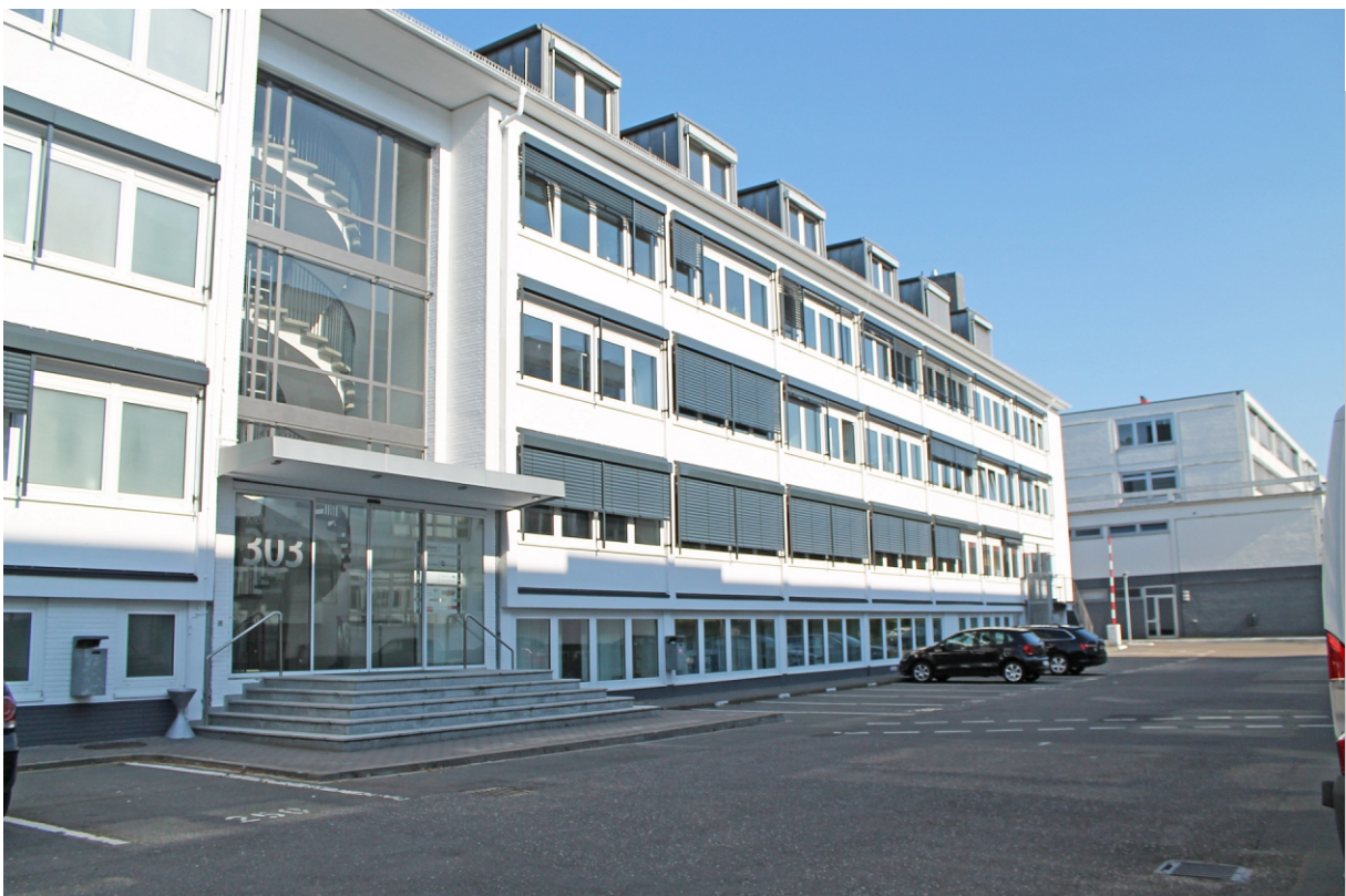
Ansichten Hofseite mit Parkplätzen
