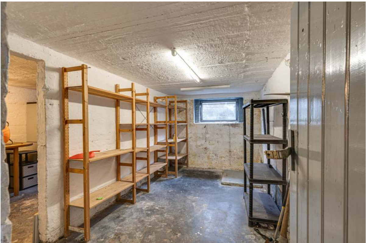
Lagerraum im Keller
