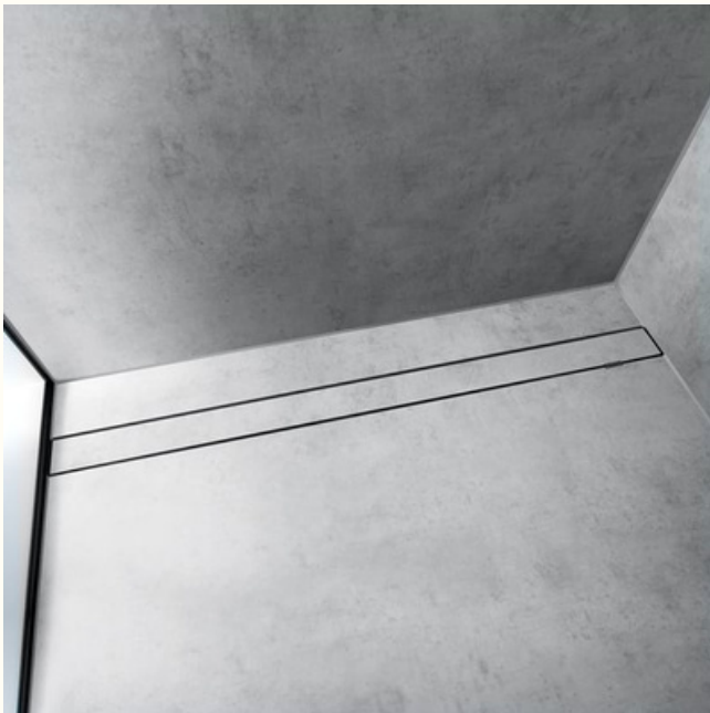
Bodengleiche Dusche mit verdeckter Rinne, gefliest
