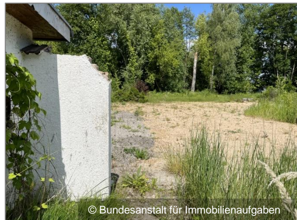
Von Nachbargarage überbauter Bereich im Südosten des Verkaufsgrundstücks
