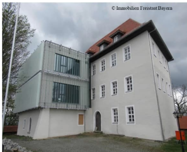
Fürstenhaus Altbau und Anbau
