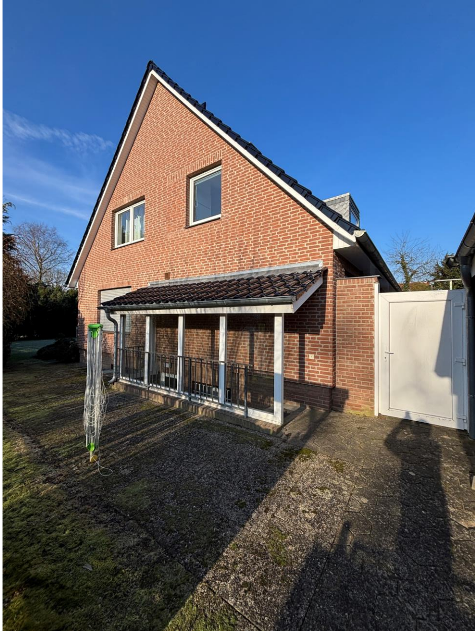
Überdachter Kellerabgang, teil überdachte Holzterrasse
