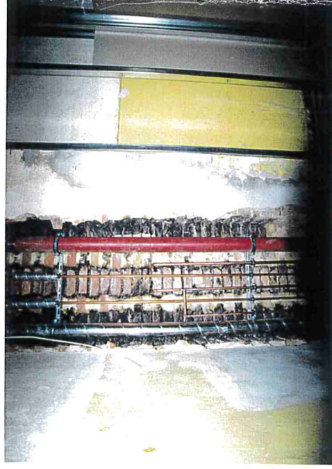
Gemeinsame Installationsstränge (Heizung, Lüftung, Kalt-/Warmwasser, Abwasser)
