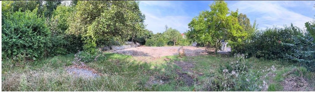
© IMBY: Gesamtansicht Grundstück mit Baugrube
