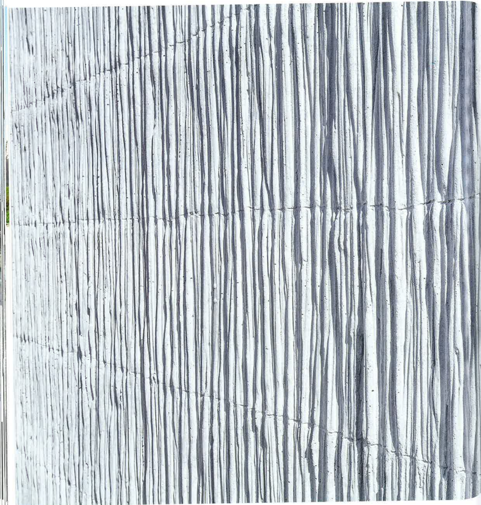
Abb. 3 (Bild links) Im Sockelbereich weisen die Gebäude reliefartige Oberflächen auf
