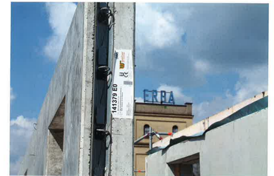
Abb. 4 (Bild oben) Die Fassade besteht aus gedämmten Architektur- betonelementen, die in Sandwichkonstruktion gefe- tigt wurden
