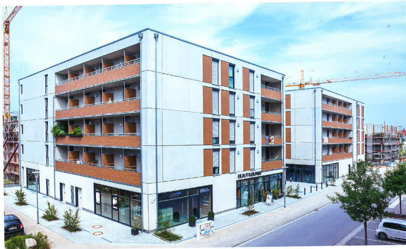
Abb. 1 (Bild oben) Auf dem Gelände der früheren Baumwollspinnerei ERBA entstand eine Wohnanlage für 120 Studierende
