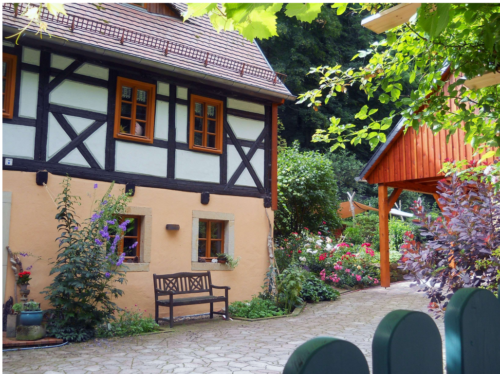
Nachbarbebauung - Schachtberg 5 – unter Denkmalschutz stehendes Fachwerkhaus aus dem 16.Jh.
