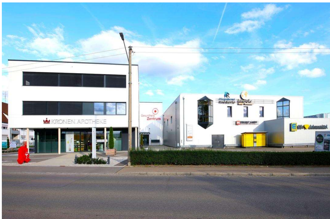
Frontansicht des Gesamtkomplexes
