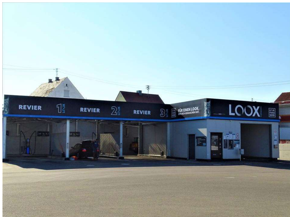
neuer Autowaschpark ist ebenso auf dem Areal
