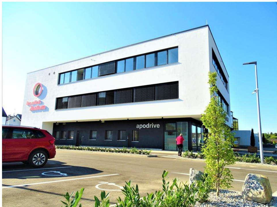
Außenansicht Gesundheitszentrum - Ist-Stand
