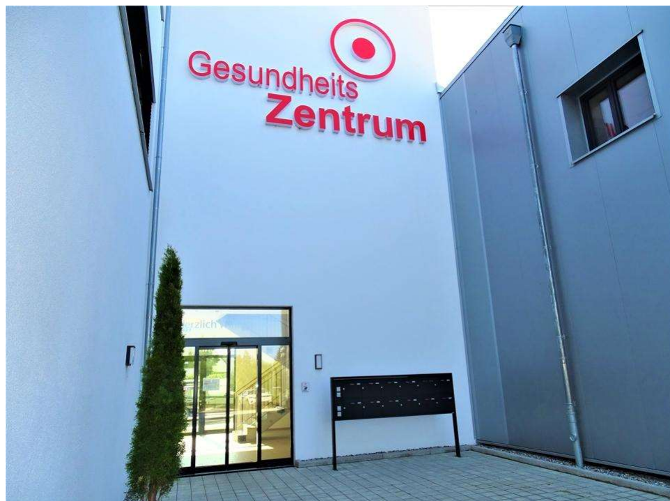
elektrische Türen mit moderner Briefkastenanlage
