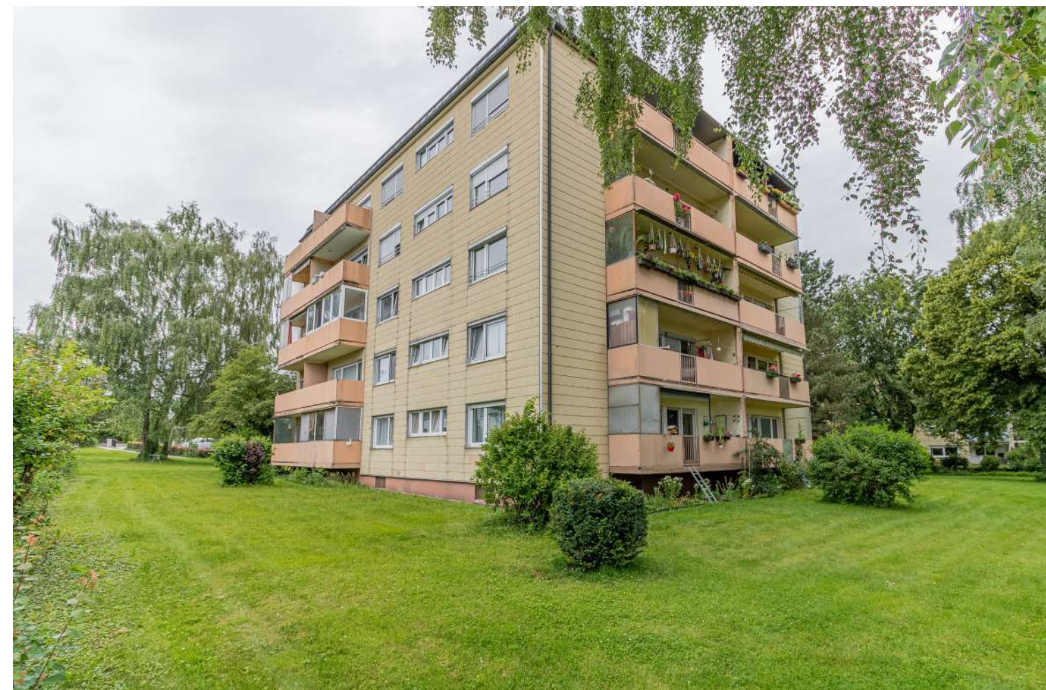
Ihr neues Zuhause in einer gepflegten Wohnanlage
