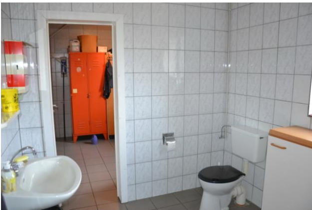
17 - Wasch- und Umkleideraum
