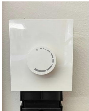
Flächenheizung TECE Einzelraum- Temperaturregelung mit Thermostatventil
