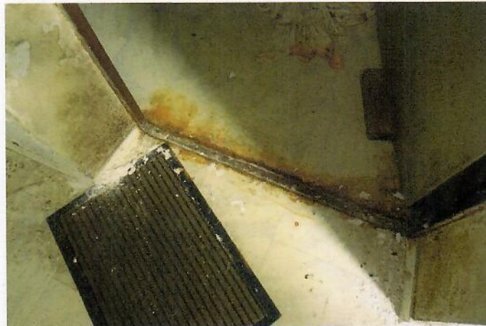
Korrodierte Türzarge
