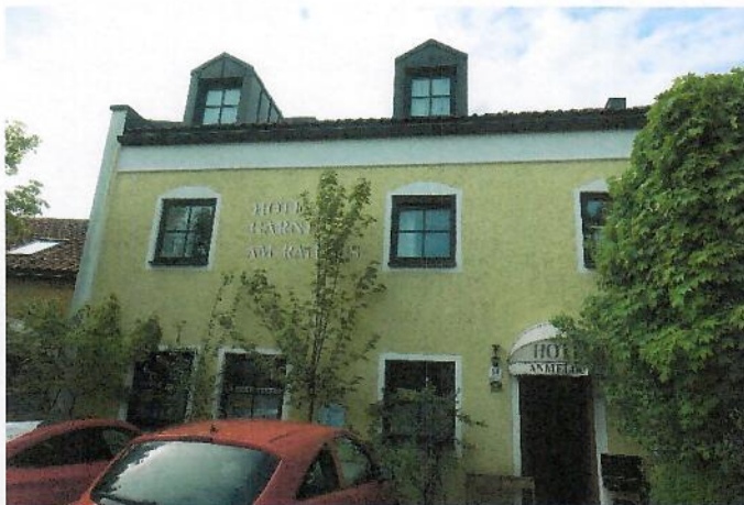
Nordseite mit Eingangsbereich
