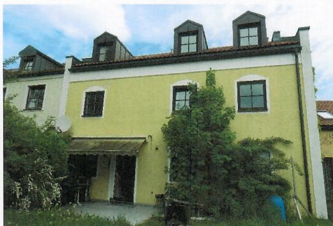
Südseite mit Terrasse
