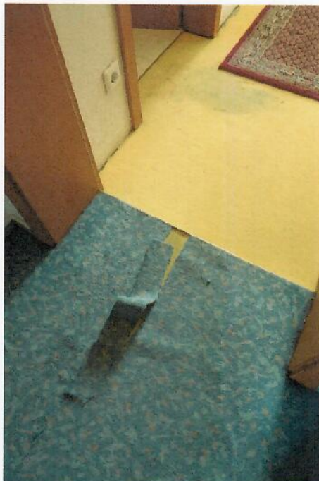
Schadhafte Bodenbelege in OG und DG
