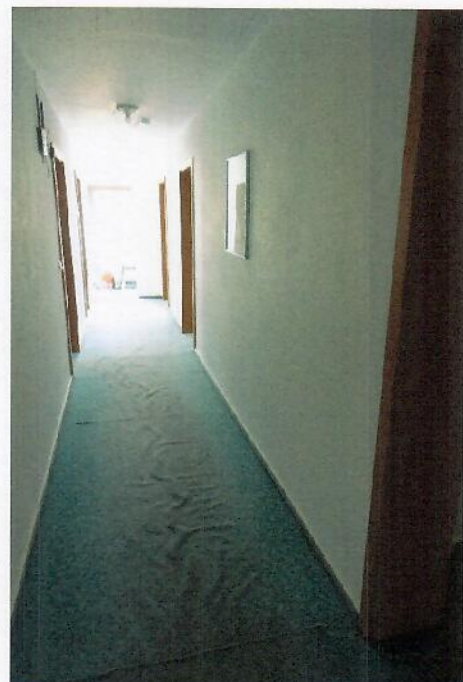
Schadhafte Bodenbelege in OG und DG
