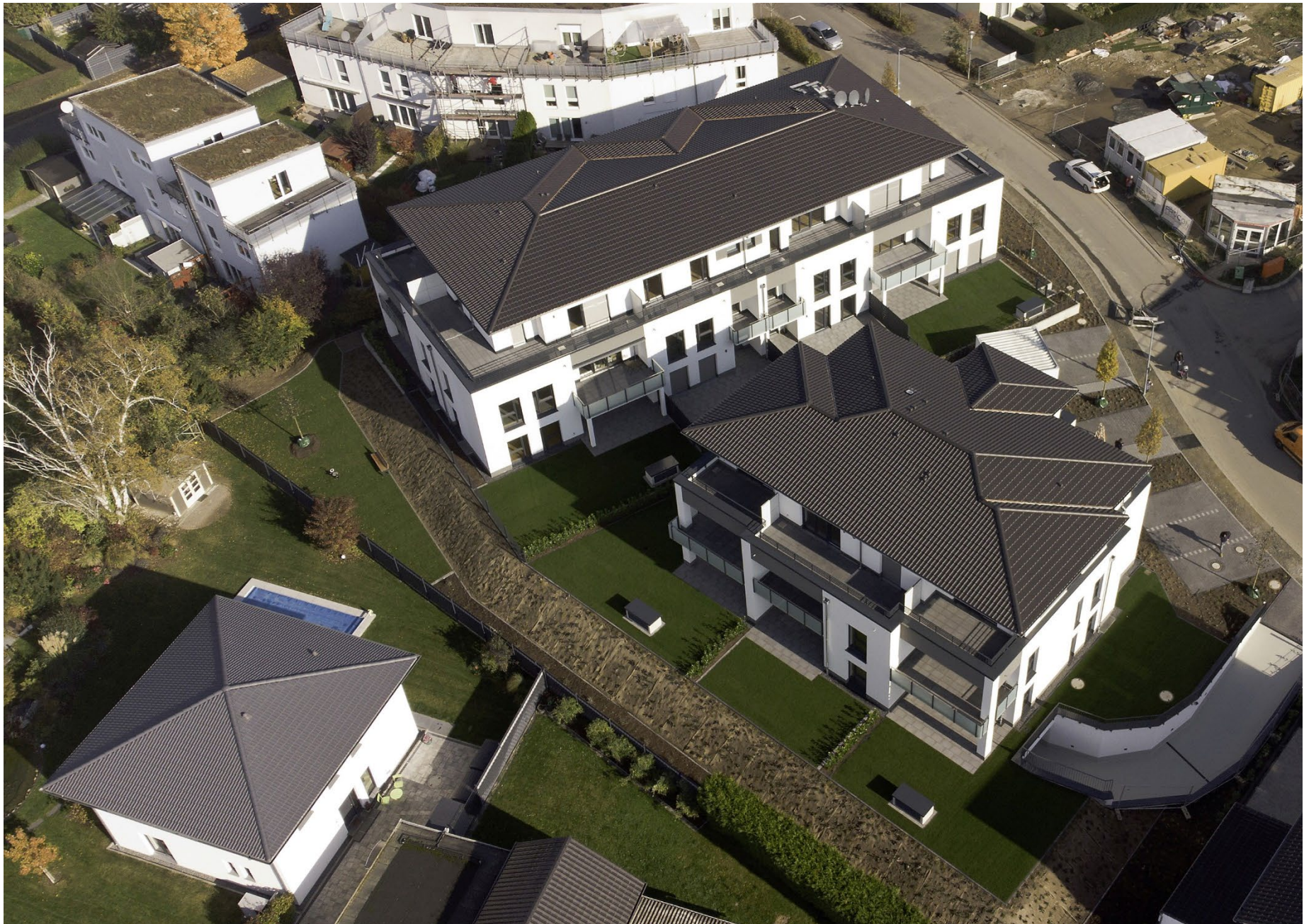
Referenz- und Qualitätsbilder - fertiggestelltes Neubauprojekt in direkter Nachbarschaft, 63486 Bruchköbel, Savignyring 61
