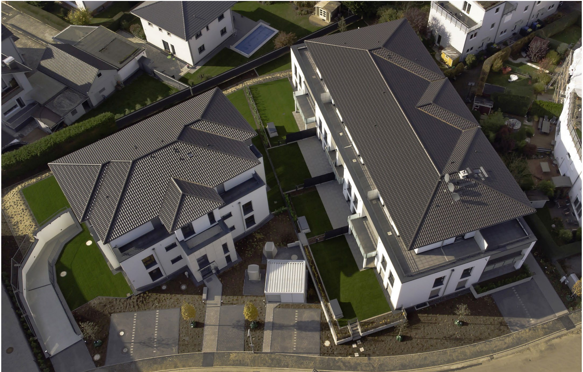
Referenz- und Qualitätsbilder - fertiggestelltes Neubauprojekt in direkter Nachbarschaft, 63486 Bruchköbel, Savignyring 61
