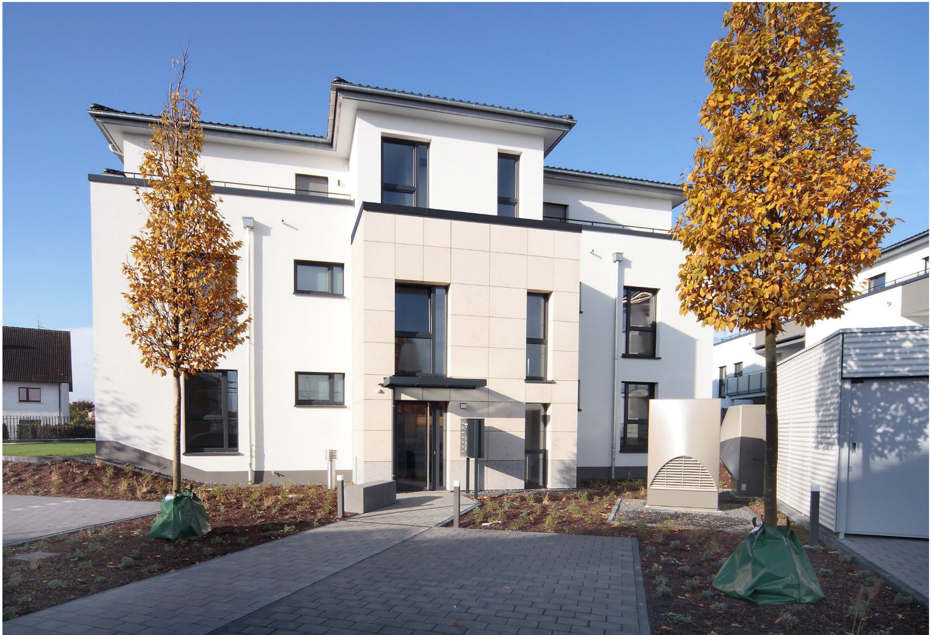
Referenz- und Qualitätsbilder - fertiggestelltes Neubauprojekt in direkter Nachbarschaft, 63486 Bruchköbel, Savignyring 61
