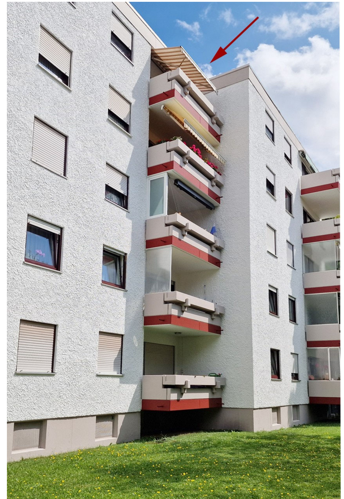
Ansicht West / Balkon
