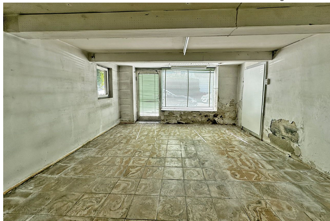
Laden im ehemaligen Wohnteil
