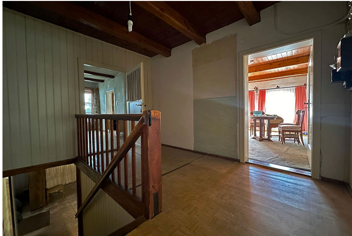
Treppenhaus im ehemaligen Wohnteil
