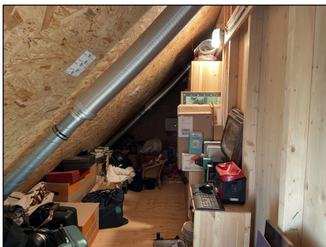
Dachgeschoss, nicht ausgebauter Teil.
