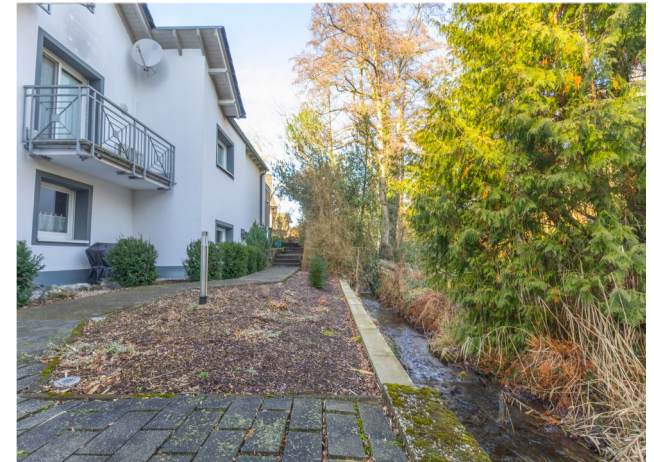
Haus & Gartenansicht direkt am Wannebach
