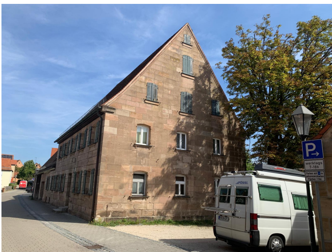
Blick von der Westseite (Strassenzufahrt)
