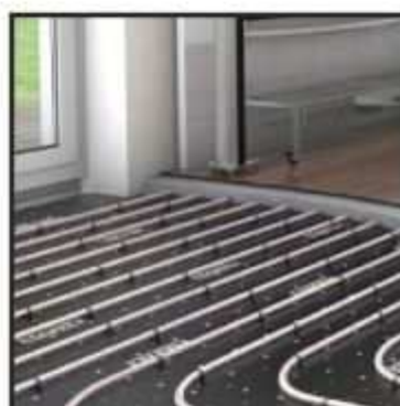
Fußbodenheizung
