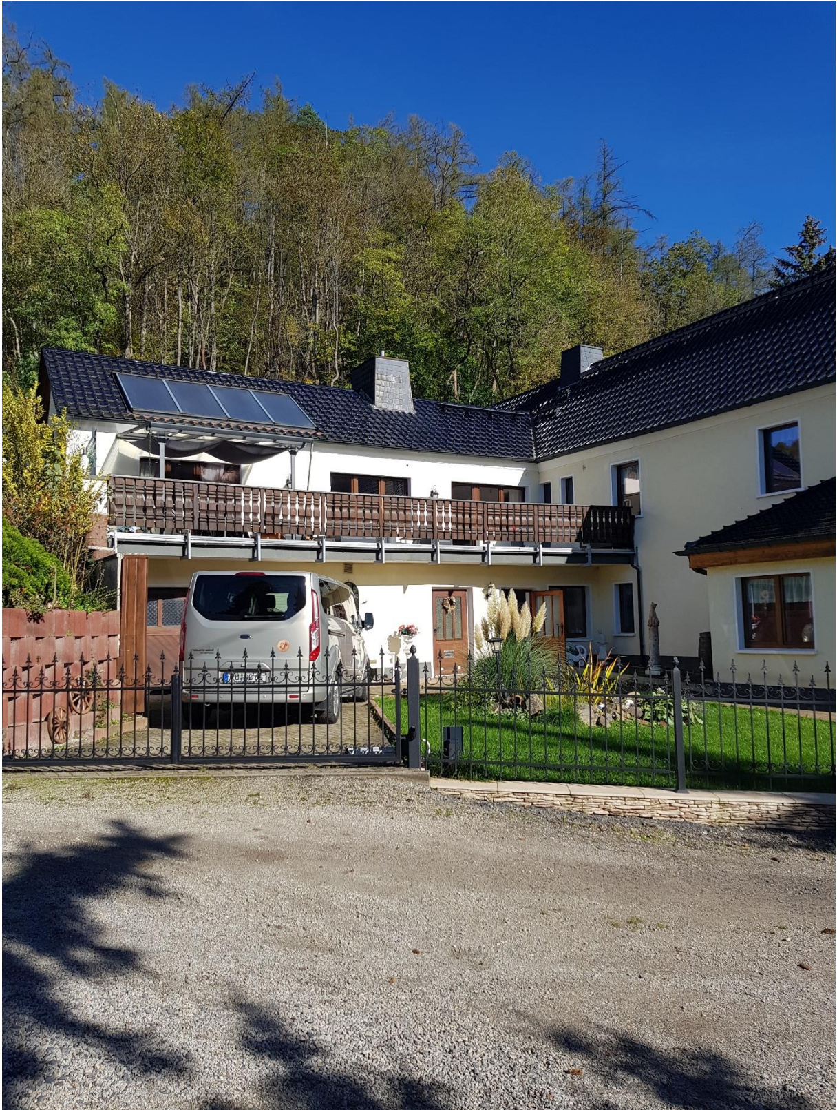
Ansicht mit großer Terrasse im OG
