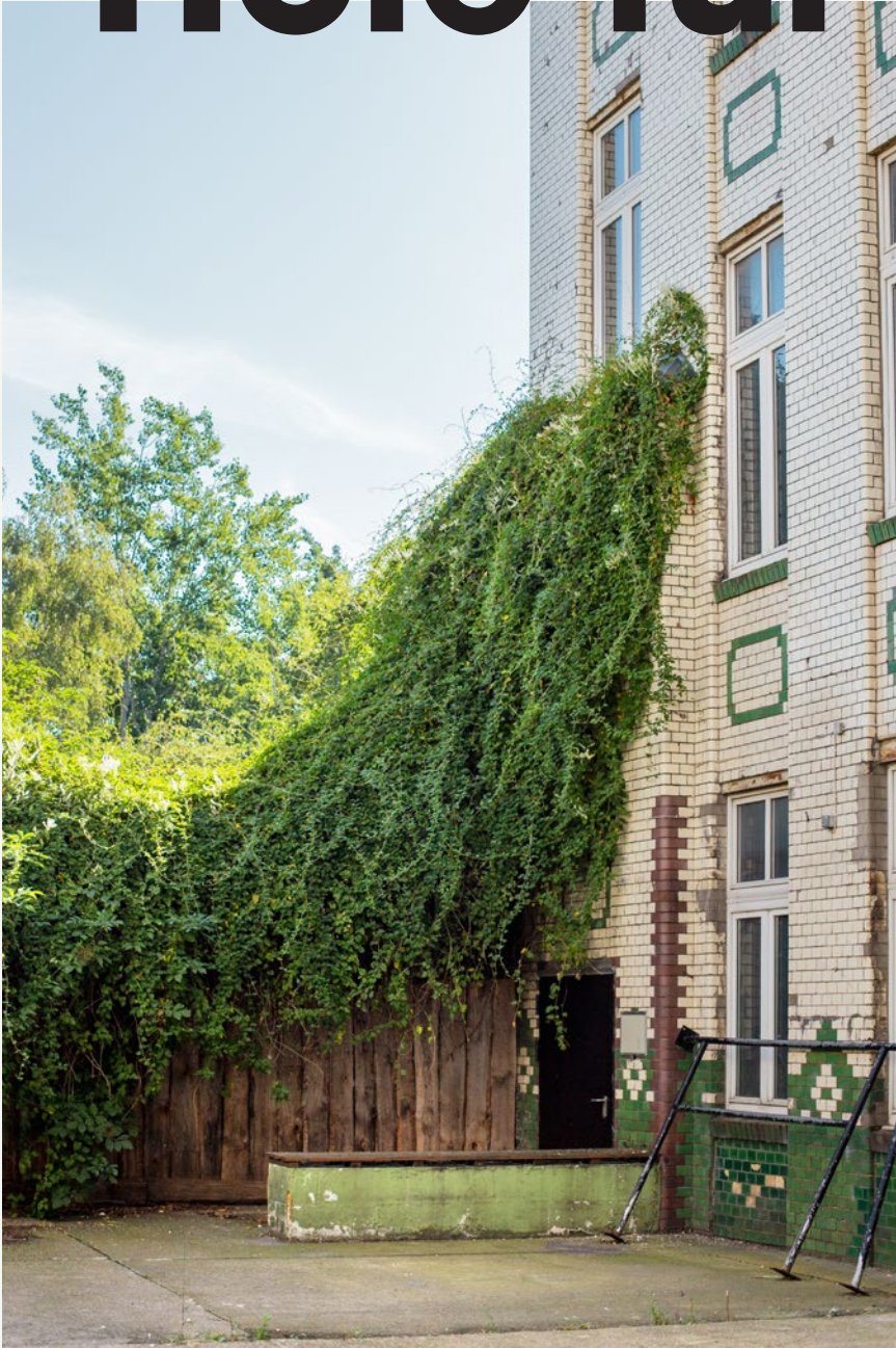
Foto: The PettCo Bestandsgebäude vor der Sanierung
