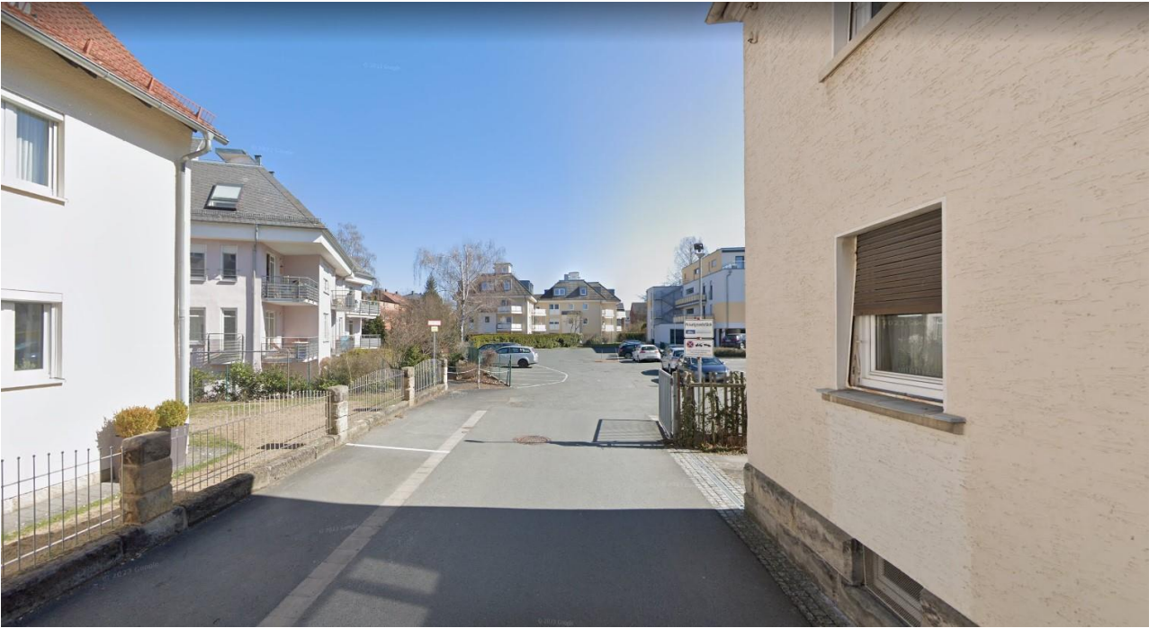
Zufahrt/Kanalanschluss an der Grundstücksgrenze
