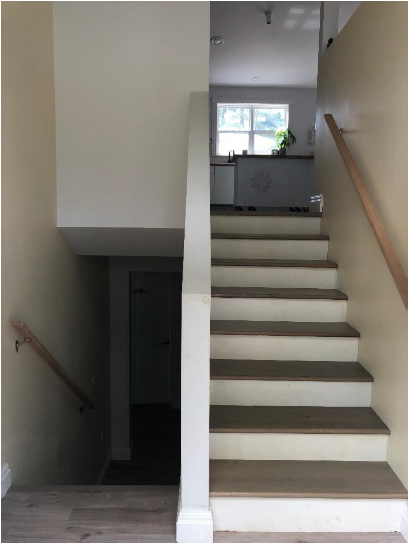
Eingangsbereich zum Ober- bzw. Untergeschoss (split entry)
