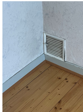
Die Luftschächte im Obergeschoss
