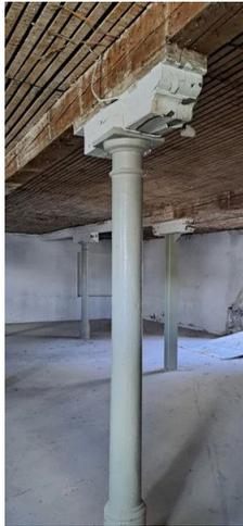
.Durch die Integration von Bauelementen aus der Industrienutzung, wie z.B. gusseiserne Stützen, alte Schaltelemente der Elektroinstallation und die Kranbahn des Kesselhauses soll das Treppenhaus auch ein Erinnerungsort an die ehemalige Maute-Fabrik sein.
