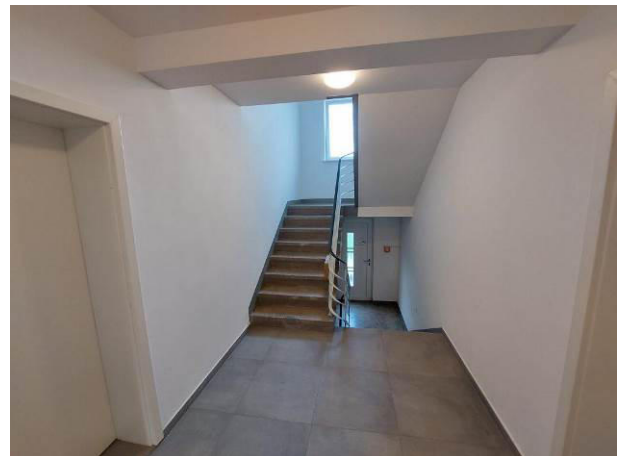
Erdgeschoss Treppenhaus und Zugang zum Gemeinschaftsgarten
