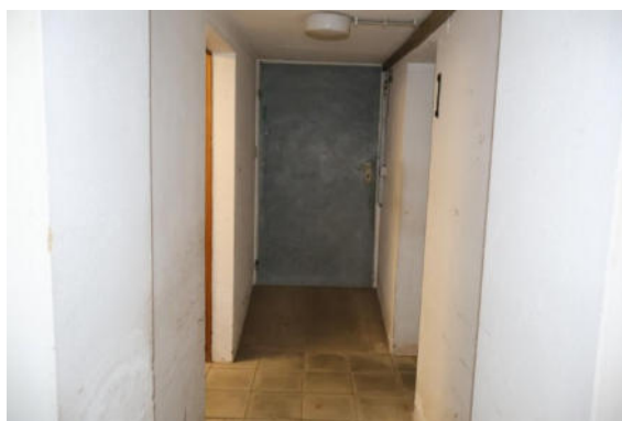
Abb. Keller mit Ausgang zur Garage
