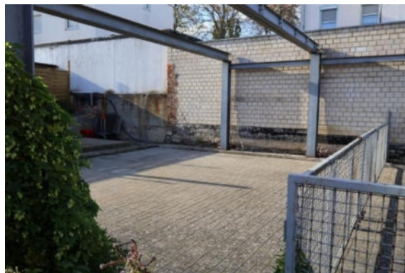
Abb. Außenanlagen Vorbereitung Garage
