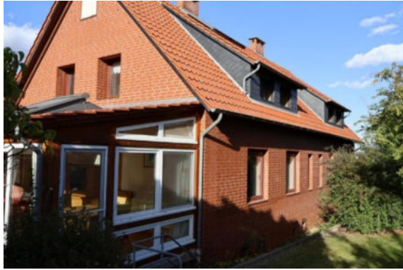
Abb. Gebäudeansicht Rückseite
