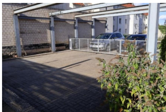
Abb. Außenanlagen Vorbereitung Garagen
