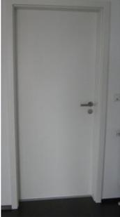
**Türblatt:** Fertigtürblatt, FT-Standard, Röhrenspan, Postforming-Rundkante Oberfläche: CPL Esche weiß-Repro. Oder gleichwertig.
