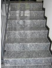
3 Läufe von KG bis DG als Stahlbetontreppe. Belag aus poliertem Serizzo.
