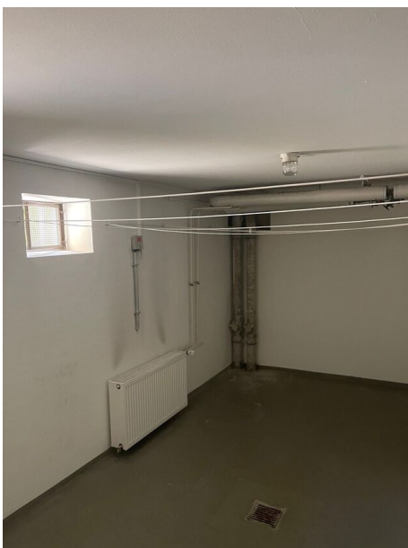
Trockenraum mit Fenster
