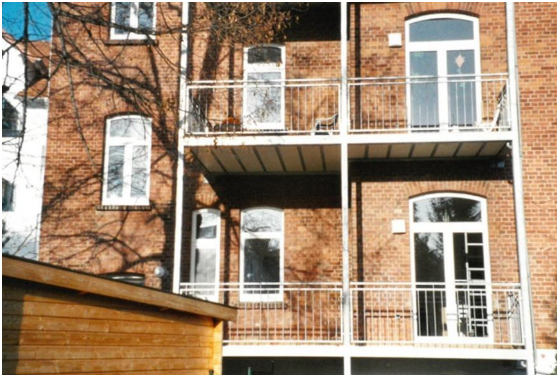
Ansicht von hinten
