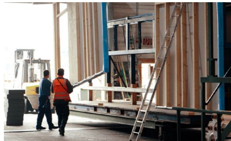
Die fertigen Wände werden verladen, termingerecht zur Baustelle geliefert und vor Ort aufgestellt.
