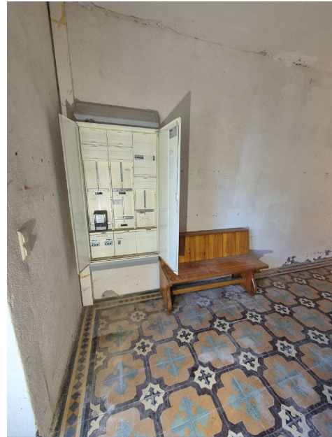
Zähleranlage
