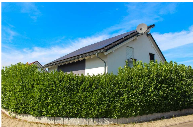
Außenansicht – PV-Anlage / Süd-Ausrichtung
