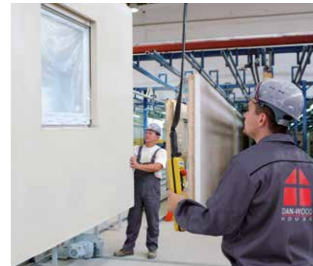
Die Wände werden in der Fabrik vorgefertigt...
