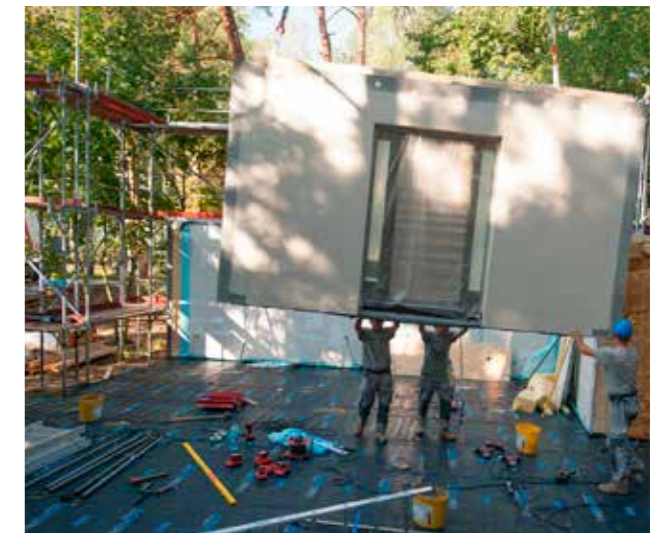
... auf LKW zum Bauplatz transportiert...
