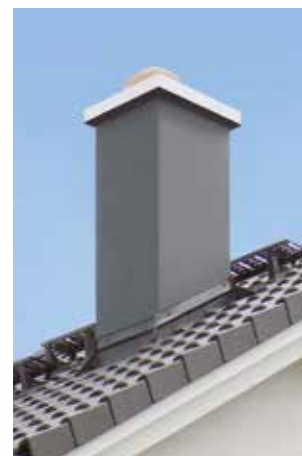
Der Schornstein wird in der Dachfarbe gestrichen***
