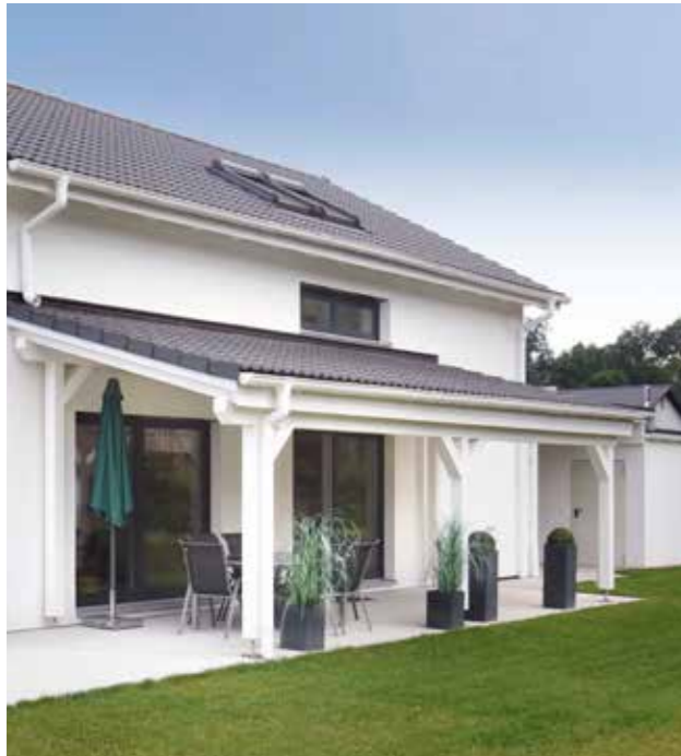
Solides Dach über der Terrasse
