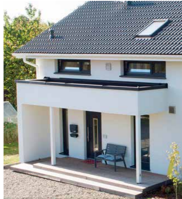
Moderne Flachdachversion einer Eingangsüberdachung
